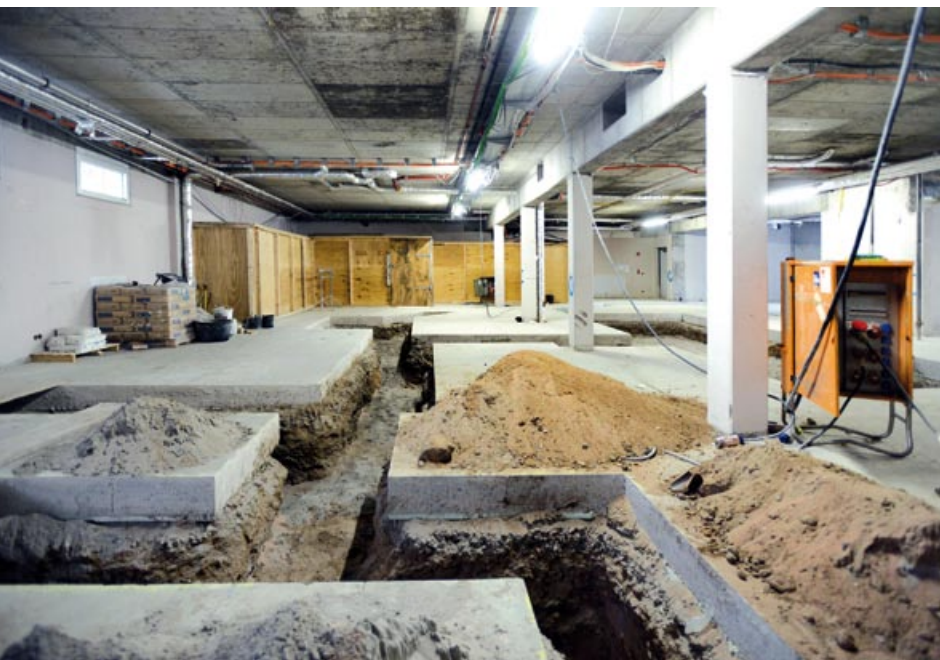
Im ehemaligen Lager muss noch viel gebaut werden, bevor die Zentralsterilisation einziehen kann.
