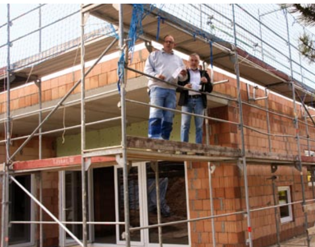
Kita-Bau: Dachdecker Thomas Styner (l.) und Dieter Weiler von der Bauabteilung der Diakonissen Speyer-Mannheim beim Richtspruch.
