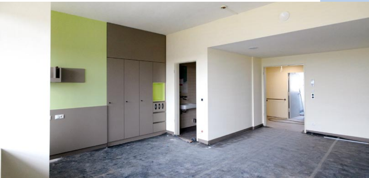
Fast fertig: Blick in eins der renovierten Patientenzimmer.
